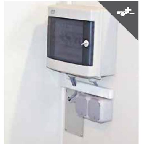
Sicherungskasten mit Steckdosen
