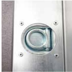
8 Zurrmulden versenkt im Bodenrahmenprofil, Dekra zertifiziert
